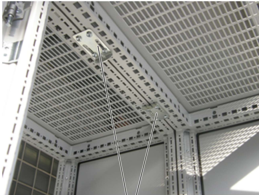
Рисунок 3-14 Соединители внутренние на нижней поперечине
