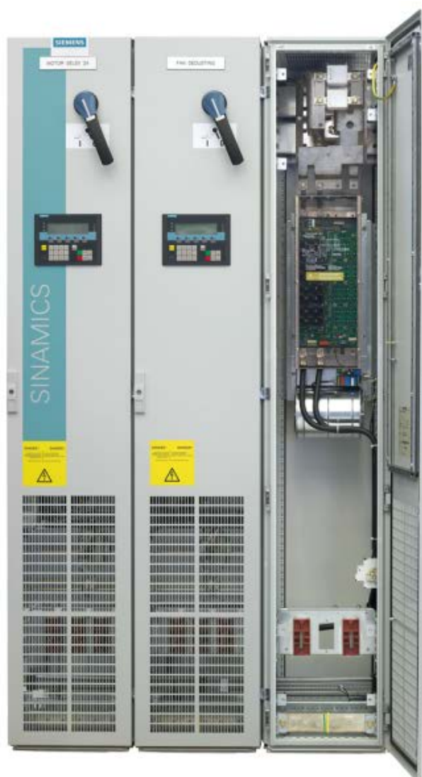
Рисунок 5-51 Центральный модуль торможения
