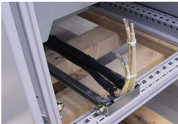
Рисунок 4-9 Линии соединений в состоянии поставки (например, транспортные единицы)
