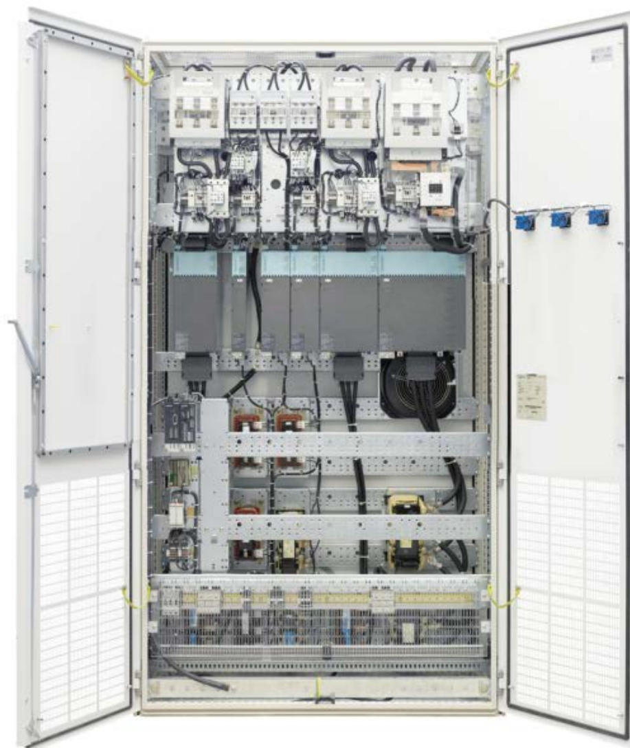
Рисунок 5-30 Модули двигателей — книжный формат
